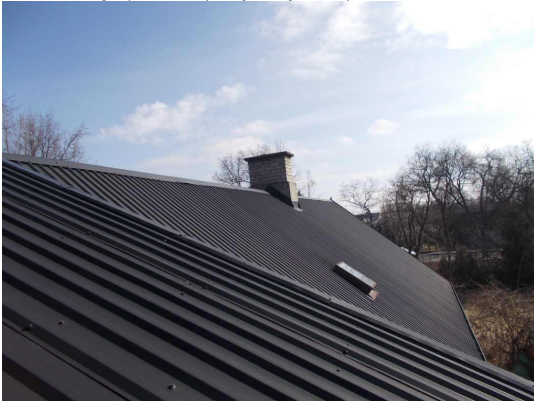
Fot. 8. Widok ogólny dachu budynku głównego, brak tynku na kominie
