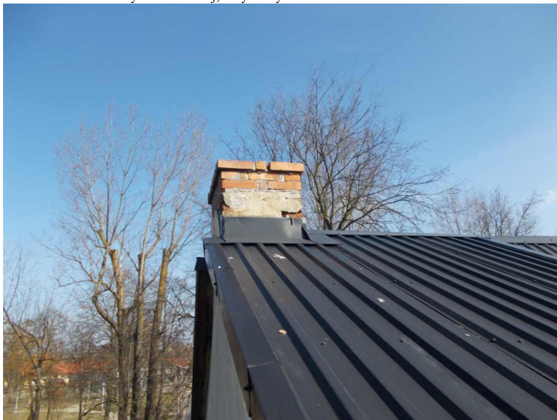
Fot. 11. Uszkodzone cegły na kominie przybudówki
