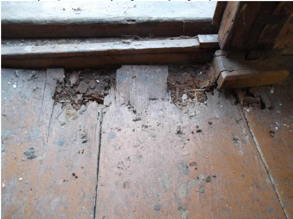
Fot. 20. Zapadnięte deskowanie podłogowe w wejściu głównym
