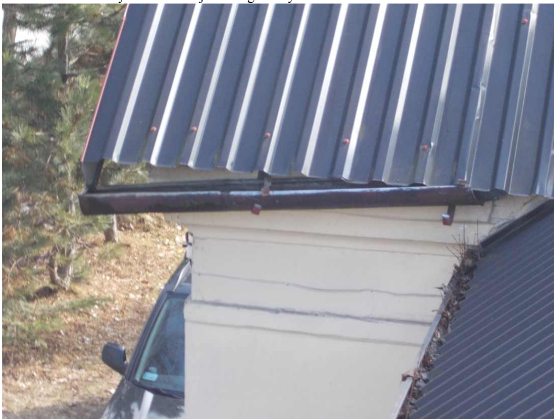
Fot. 13. Zapchana rynna, uszkodzona obróbka blacharska
