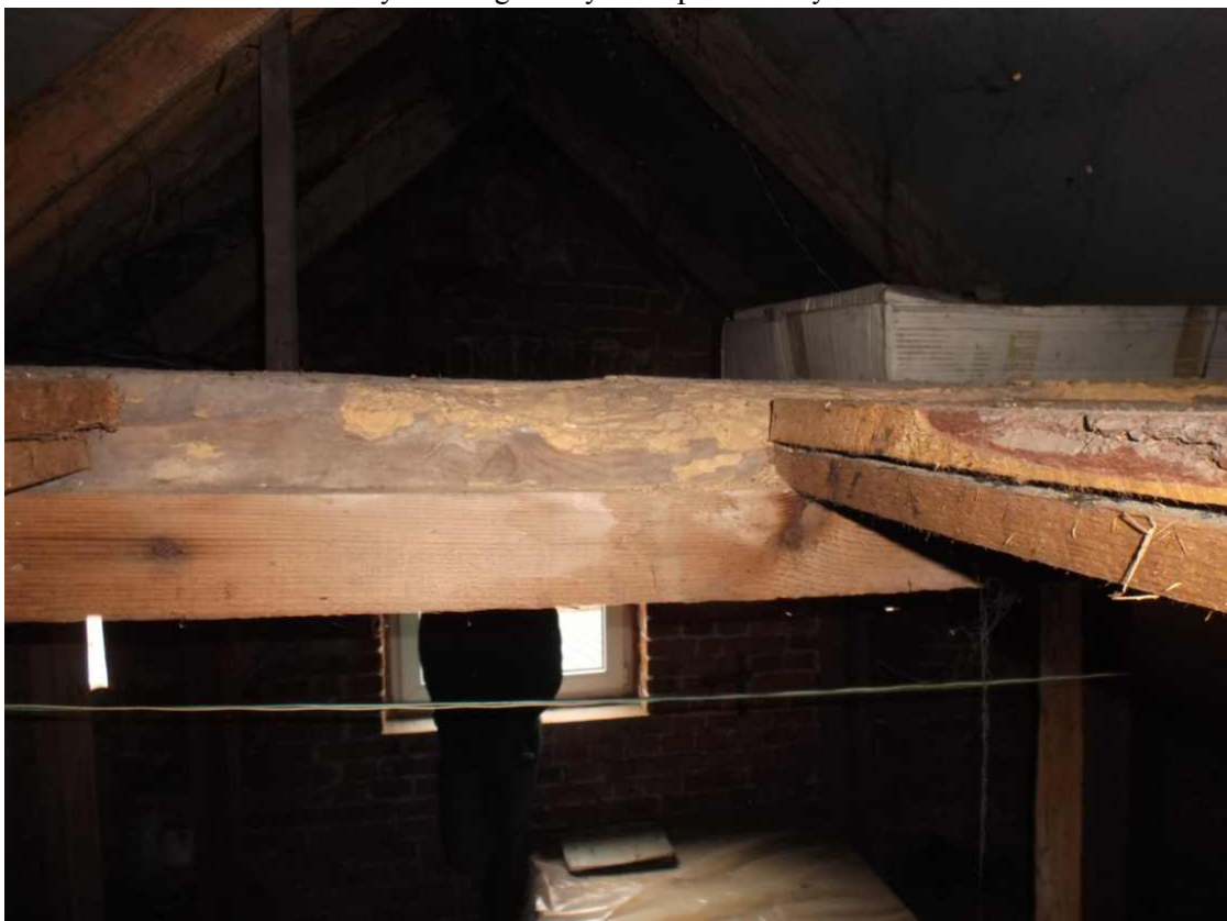
Fot. 25. Poddasze nad budynkiem głównym – spróchniały kleszcz
