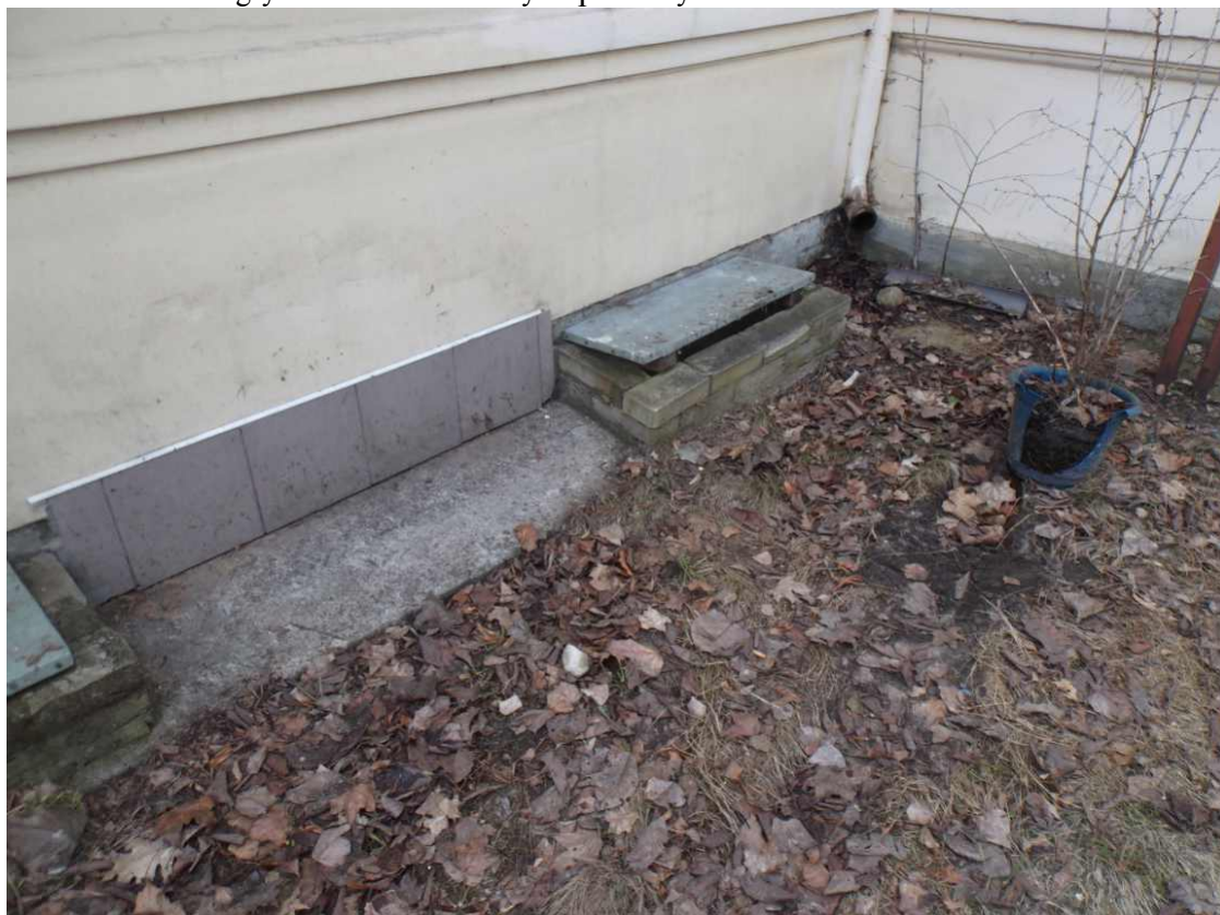
Fot. 7. Luźne cegły naświetli okiennych piwnicy
