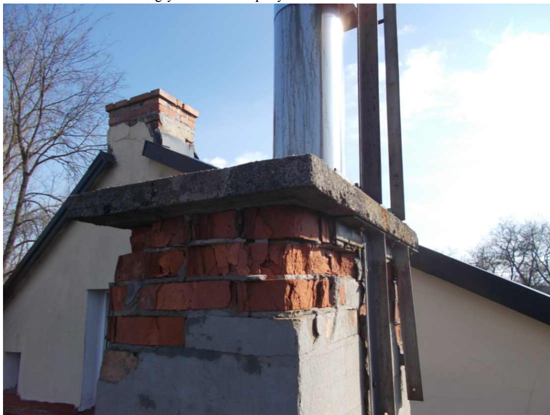
Fot. 11. Uszkodzone cegły na kominie przybudówki
