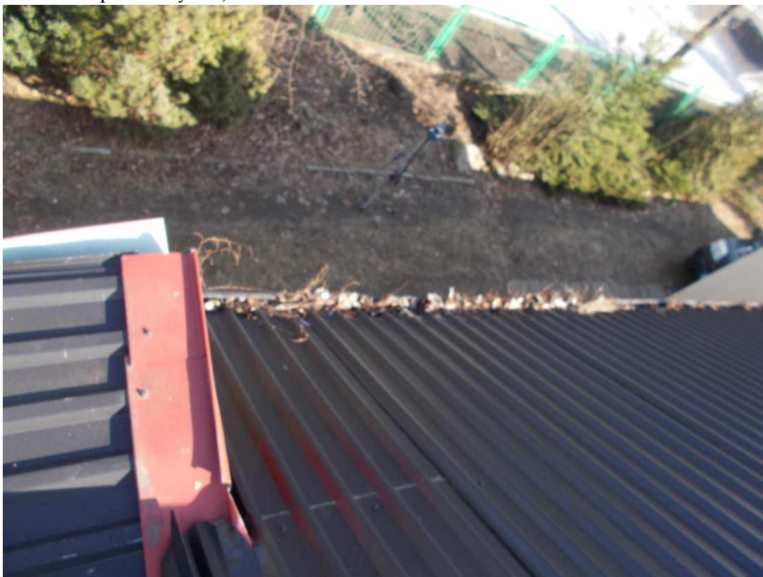
Fot. 13. Zapchana rynna, uszkodzona obróbka blacharska
