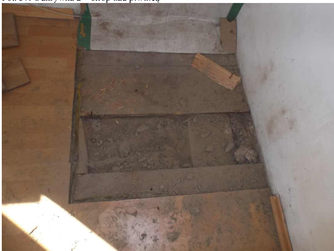
Fot. 37. Odkrywka 2 – strop nad piwnicą
